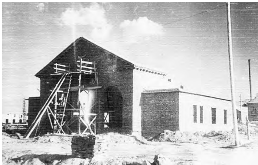
Вид на строительство первого продовольственного магазина. г. Оленегорск. Лето 1950 г.
