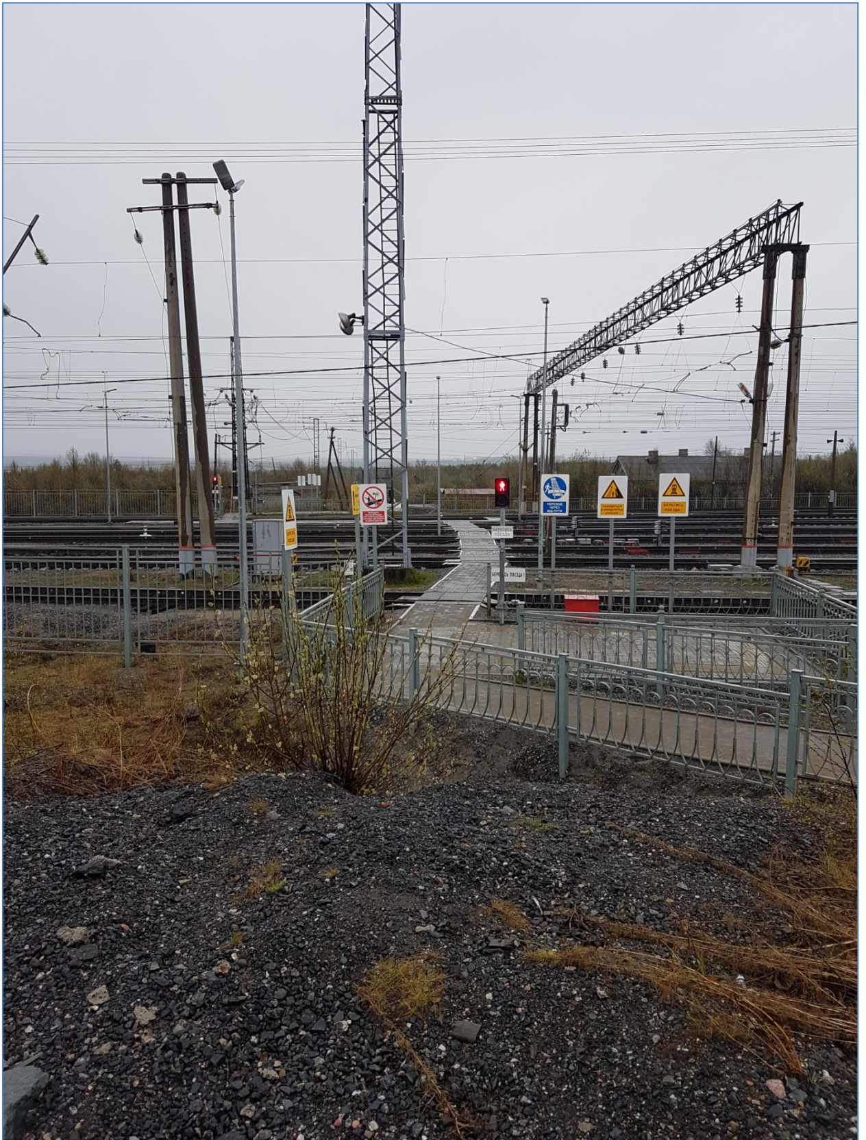
Рисунок 4 — Реконструированный наземный переход через ж/д пути
