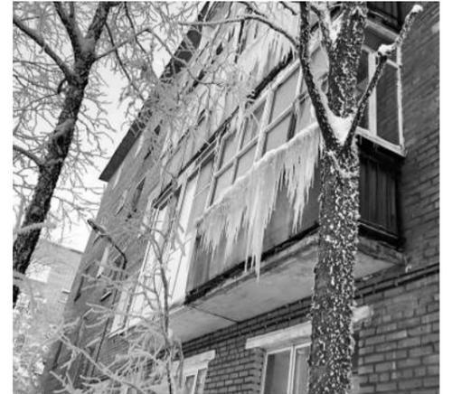
Это стало еще одной проблемой нынешнего зимнего периода. Связано это в первую очередь не с технологией очистки крыш зданий, а с ветхостью жилфонда и давно не проводившимися ремонтными работами — протекание кровель происходит в основном не в карнизной зоне, а в центральных частях крыш жилых домов.
