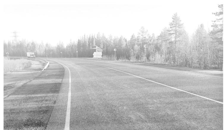
На автоподъезде к Оленегорску завершен ремонт дороги общего пользования регионального значения. Заменено изношенное покрытие. Укреплены обочины. Нанесена разметка со световозвращающими элементами.
